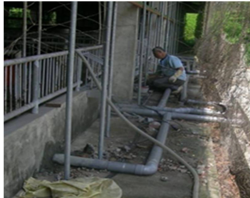
圖 1. 雨水、廢水分流可減少廢水排放量
